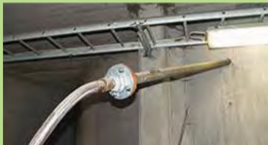
サイロのランス設置
