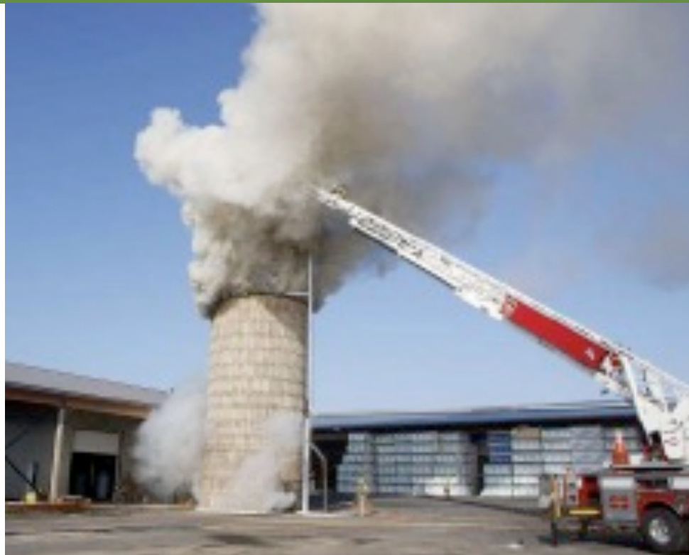
木材チップの入ったサイロ内の火災; Lancaster, PA, 2015 年12月; Lancaster Online.
