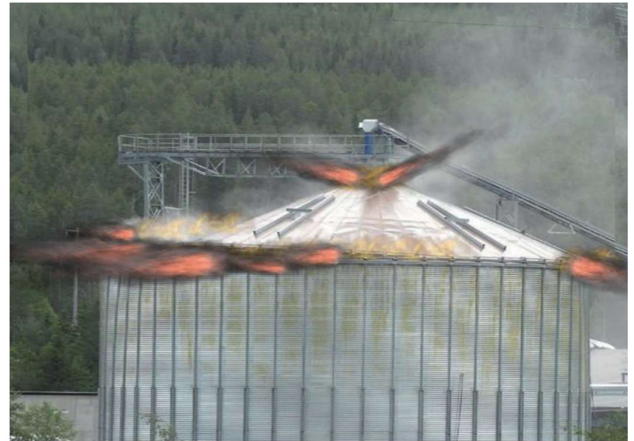
実際に発生したサイロ爆発。おそらくは、燻りを消そうとして静電気が発生し、上部空間のガスに着火したのが原因であろう。 (courtesy of Dag Botnen, Hallingdal brann- og redningstenste iks, Norway)
